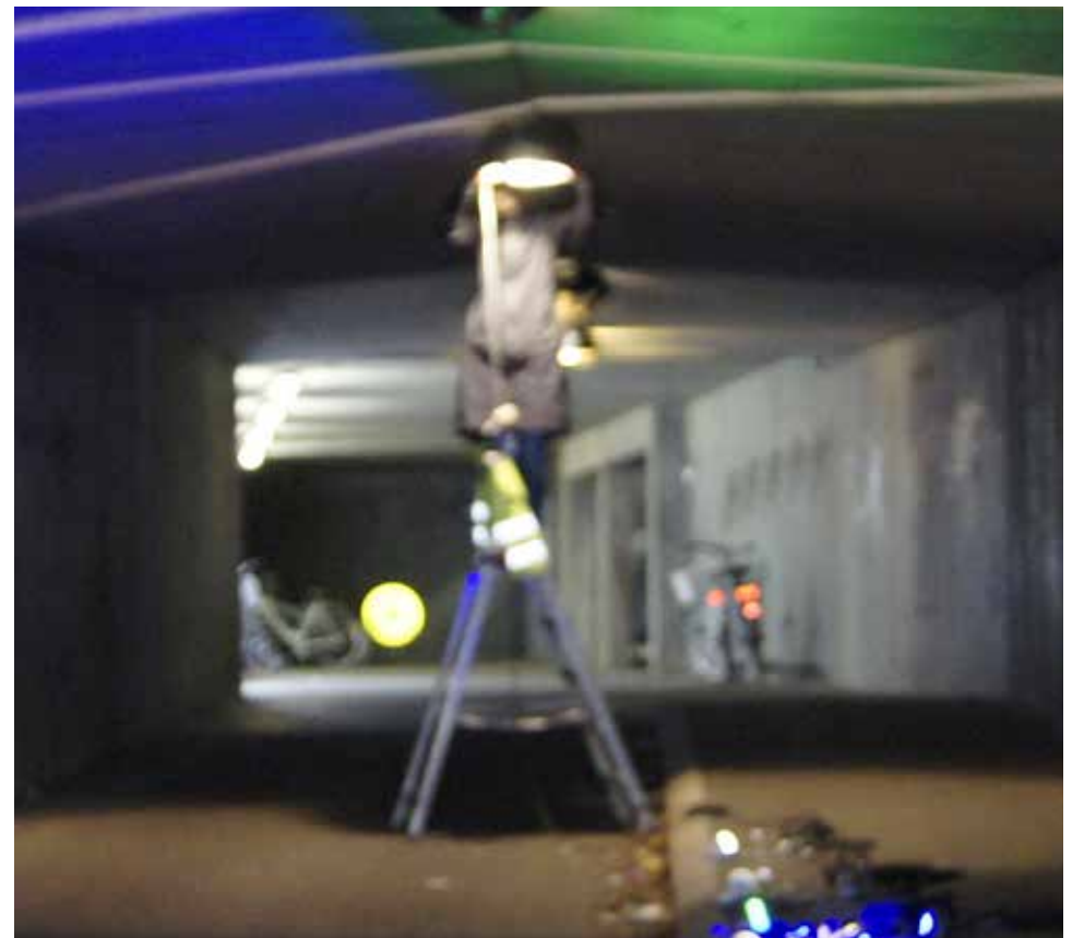
Fra lystest – i baggrunden ses forsøg med refleksskive, der havde en meget kraftig refleksion af dagslyset. Den færdige skive er større og placeres højere på væggen.
